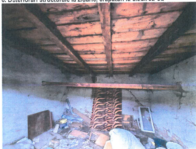
6. Deteriorări structurale la zidărie, crăpături la clădirea C2
